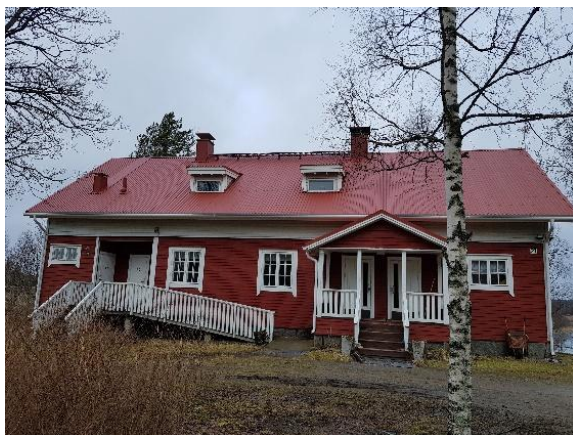
Kuva 1. Vähäsillan leirikeskuksen päärakennus.
